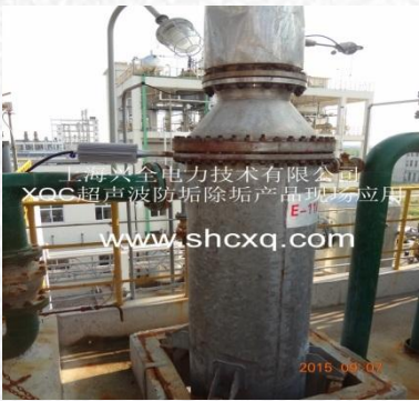
为了增加除垢效率，特设计开发了XQC-Q1超声清洗设备，该设备XQC清洗头，由多组超声波换能器组成，能产生高强度的超声波，对垢层进行清洗。清洗头由XQC-Q1超声清洗设备提供。 2021年11月30日
